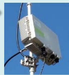
⑬設置柱に無線機を取り付けます。
