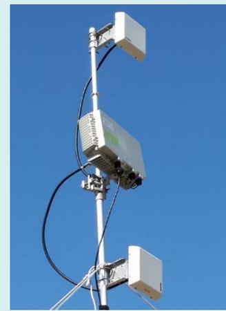
⑰アンテナの上下左右の角度を対向するアンテナの方向を向くように微調整します。伸縮ポールを使用する場合は適当な高さまで伸ばします。
