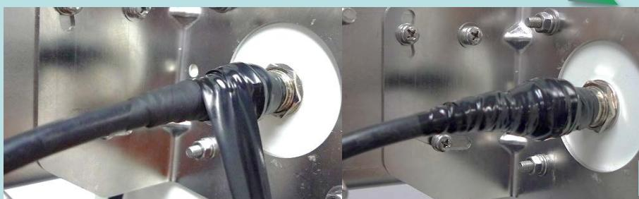
⑧「耐候性ビニルテープ」を「自己融着テープ」の上に1/2掛け(テープ幅の約半分が重なるように)でケーブル方向に向かって1往復以上巻き付けます。
