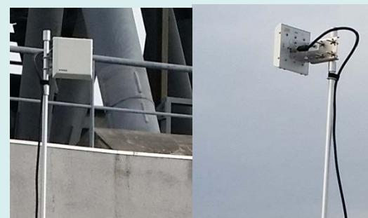
⑨アンテナの上下左右の角度を対向するアンテナの方向を向くように微調整します。
