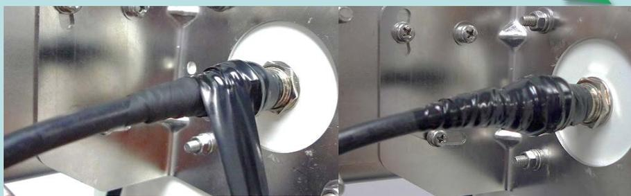
⑧「耐候性ビニルテープ」を「自己融着テープ」の上に1/2掛け(テープ幅の約半分が重なるように)でケーブル方向に向かって1往復以上巻き付けます。その際、テープの合わせ目から水が入らないよう注意し、巻き付け方向は「自己融着テープ」と逆方向になるように巻き付けます。
