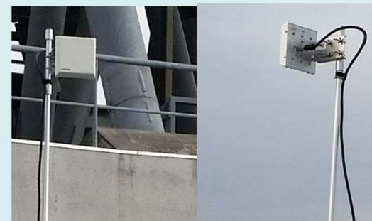
⑨アンテナの上下左右の角度を対向するアンテナの方向を向くように微調整します。伸縮ポールを使用する場合は適当な高さまで伸ばします。
