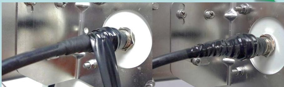
⑧「耐候性ビニルテープ」を「自己融着テープ」の上に1/2掛け(テープ幅の約半分が重なるように)でケーブル方向に向かって1往復以上巻き付けます。その際、テープの合わせ目から水が入らないよう注意し、巻き付け方向は「自己融着テープ」と逆方向になるように巻き付けます。
